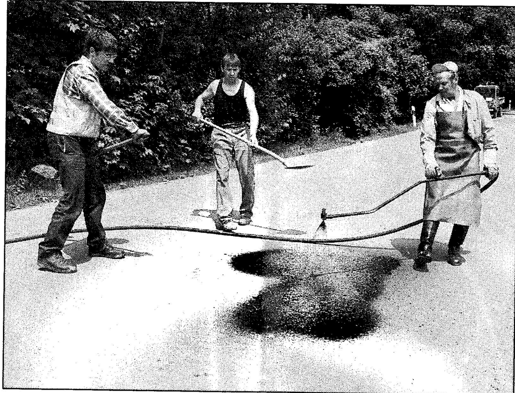
Die Straße am Jägerberg vorflicken, ehe sie demnächst mit einer Schicht Splitt überzogen wird. — Diese Aufgabe erledigten gestern vormittag Uwe Gretscher, Matthias Hänel, Willy Wuckelt (v.l.) und Wolfbert Ludwig (nicht im Bild) vom Städtischen Bauhof.
